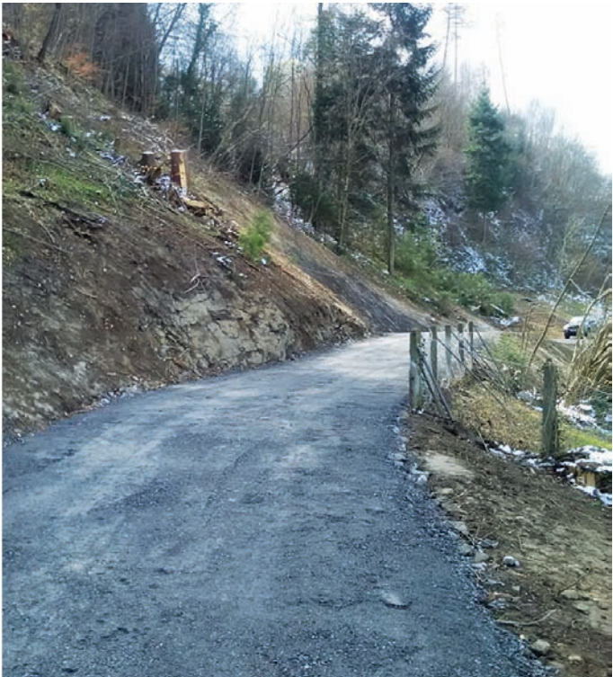
Neubau Badbüchelweg Nofels 2018
