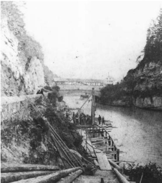
*Abb. 4: Unter schwierigsten Bedingungen wurde die Bahntrasse in der Illschlucht angelegt. Im Hintergrund die gedeckte Holzbrücke, die im Zusammenhang mit diesen Bauarbeiten abgebrochen und durch eine Stahlbrücke ersetzt wurde.*
