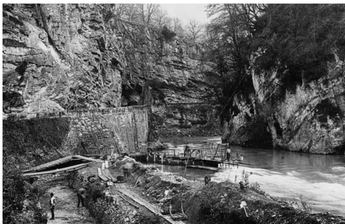
Bild 8: Errichtung des Oberwasserkanals sowie der Einlassöffnung für das Wasser der Ill und der Wehranlage (wahrscheinlich 1893, möglich wäre auch Anfang 1894). Die Chronik enthält in diesem Zusammenhang nur den einen Vermerk, dass am 21. April 1894 der Einlaufkanal zum ersten Mal ganz gefüllt wurde. Die Straße durch die Illschlucht wurde 1884/85 in den Felsen gesprengt. Der Tunnel wurde erst 1913/14 gebaut. Die damals noch schmale Schlucht wurde 1924/25 auf das heutige Ausmaß erweitert.
