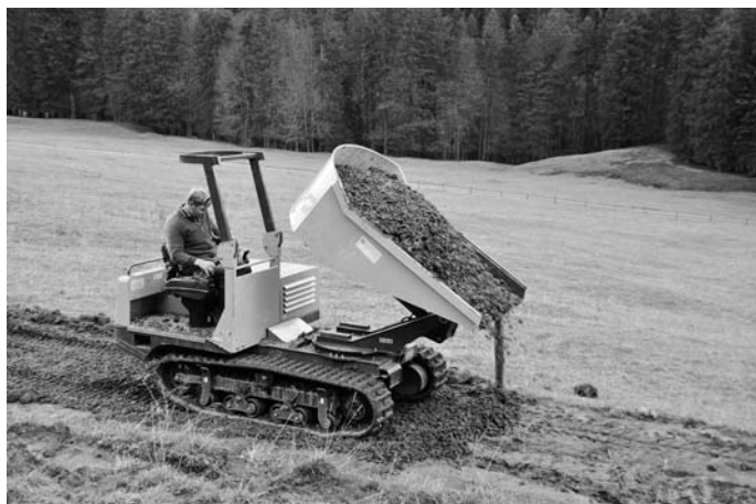
Wegreparatur vom Unteren zum Oberen Propst - Herbst 2013
