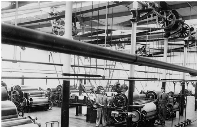
Bild 6: Saal-Transmissionen um 1900. Noch erfolgte die Kraftübertragung von den Turbinen bis zu den Maschinen auf mechanischem Weg.
