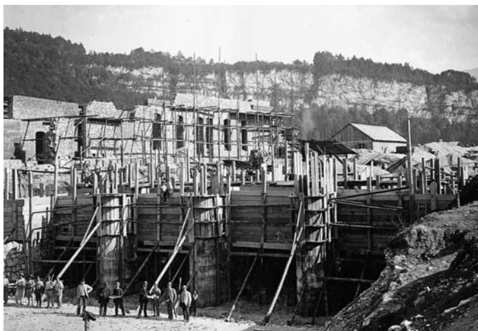
Bild 2: 12. Juli bis 11. November 1893: Errichtung der Turbinenhalle und des Fabrikgebäudes. Durch die vier großen Öffnungen im Vordergrund tritt das von den Turbinen kommende Wasser wieder aus und wird vom Unterwasserkanal aufgenommen.
