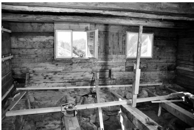
Sanierung Köchlehütte in Unterdamüls - August 2012.
