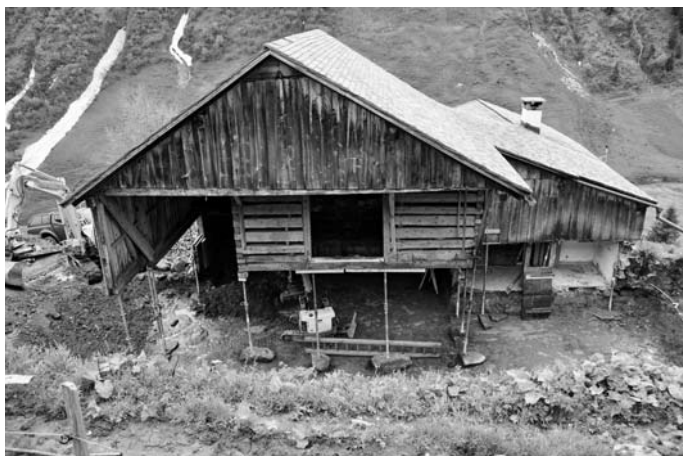
Sanierung des verkauften Objektes „Egger“ in Unterdamüls.
