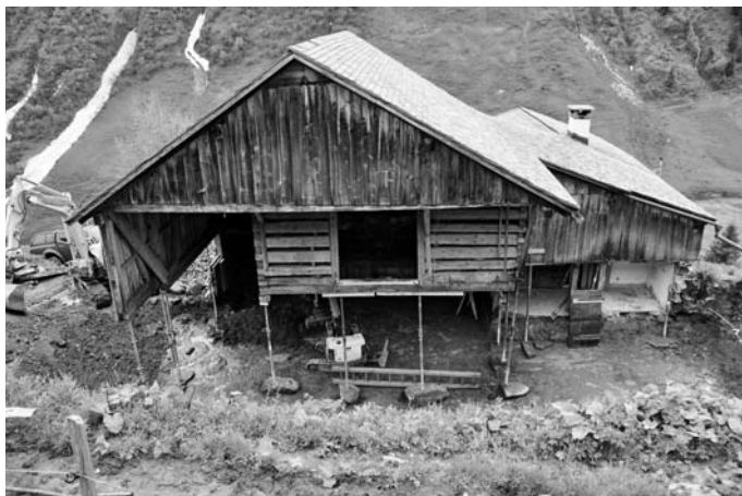
Sanierung des verkauften Objektes „Egger“ in Unterdamüls.
