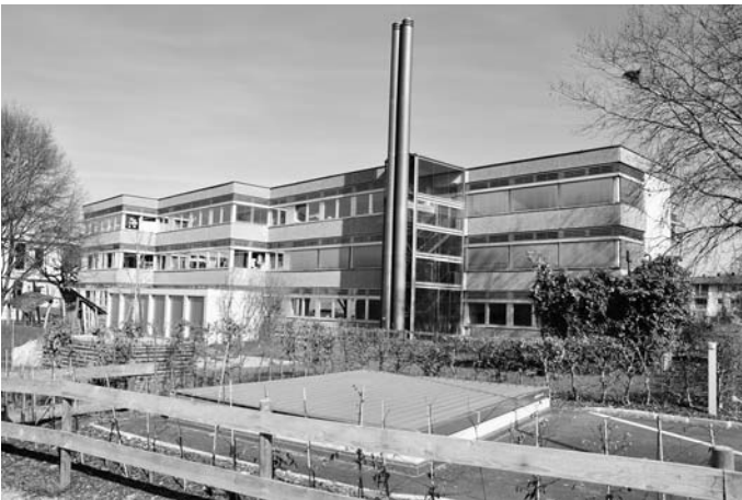
Biomasseheizwerk Bifang: Im Vordergrund die Abwurfklue, Bildmitte die Schlotte an der Hauswand der Volksschule Montfort.
