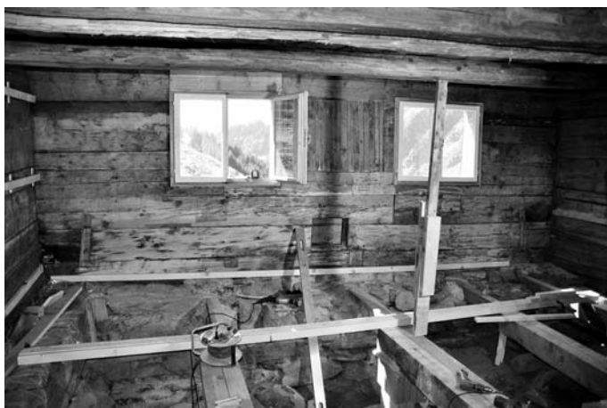
Sanierung Köchlehütte in Unterdamüls - August 2012.
