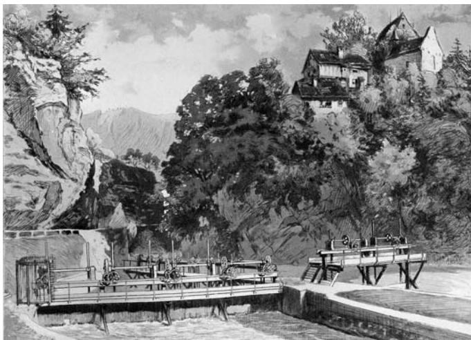
Bild 1: Die Wehranlage diente der Ableitung des Wassers der Ill in den Kanal und der Steuerung der Wassermenge. Das Bild ist 1900 oder knapp davor entstanden.
