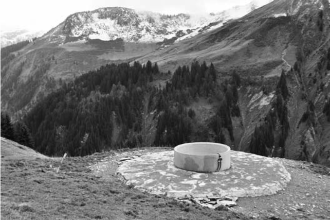
Neuer Brunnentrog mit befestigter Bodenplatte am Wanderweg von Unterdamüls zur Alpe Türtsch Foto: L. Nesensohn
