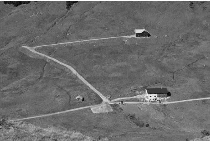
Neue Zufahrt zum Anwesen „Kathrinler“ in Unterdamüls
