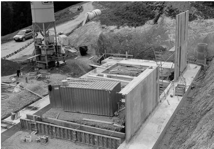
Schalungsarbeiten Bergmauer Rinderunterstand UD, 6. Oktober 2009
