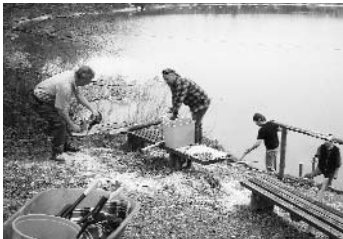
Reparaturen im Rahmen des Frondienstes
