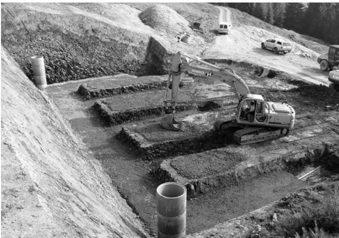
Aushubarbeiten beim neuen Rinderunterstand UD, 23. September 2009
