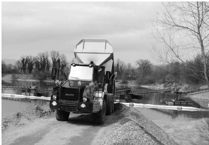
Kies vom Retentionsbecken wird in den Baggersee Paspels zur Zwischenlagerung gekippt.
