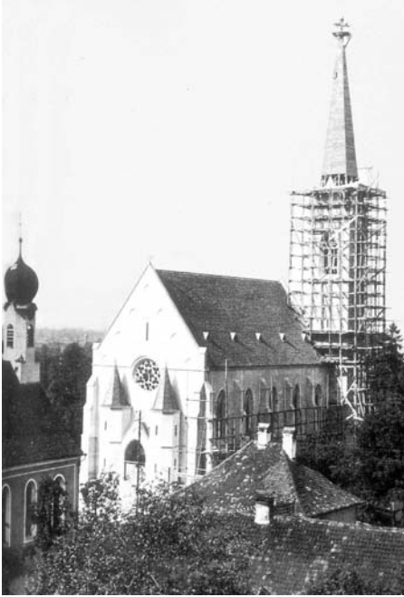
Zwischen 1901 und 1903 erbaute Josef Kröner die Pfarrkirche in Schwarzach. Im Bild ist rechts die noch mit einem Baugerüst versehene neue Kirche zu sehen, links die
