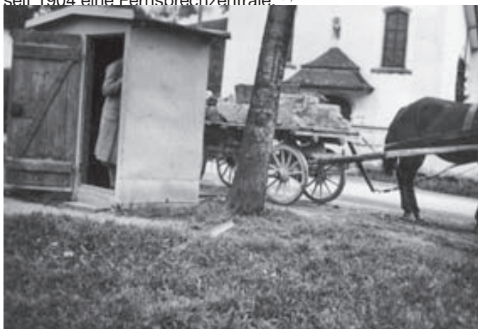
Die Brückenwaage in Nofels. Das mit Steinen vom Steinbruch Nofels beladene Fuhrwerk steht auf der Brückenwaage, im Waaghäuschen wird das Gewicht abgelesen. Im Hintergrund die Pfarrkirche Nofels.
