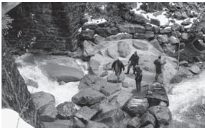
Neuer Sohlgurt zur Sicherung der vom Garnitzabach unter- spülten Widerlager der Badwaldbrücke in Laterns.
