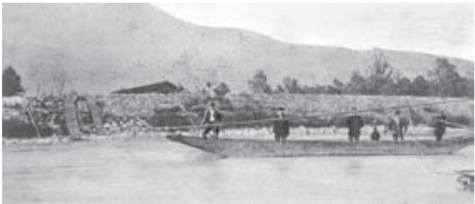
Die Rheinfähre bei Bangs. Gut sichtbar das über den Fluss gespannte Seil, an dem die Fähre befestigt war. An Bord auch ein Zöllner. Postkarte aus dem Jahre 1905. (STAF)
