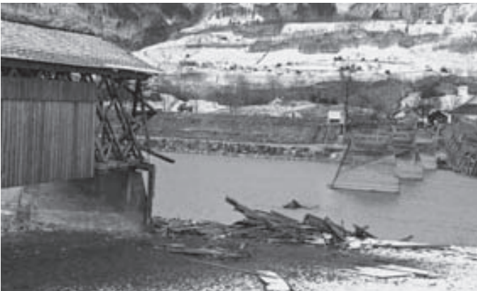
Die zerstörte Rheinbrücke nach dem Föhnsturm vom 27. 11. 1965. Foto Ing. Stieger.
