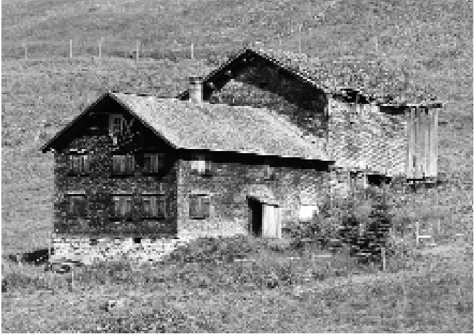
Dünserhaus Unterdamüls vor der Renovierung
