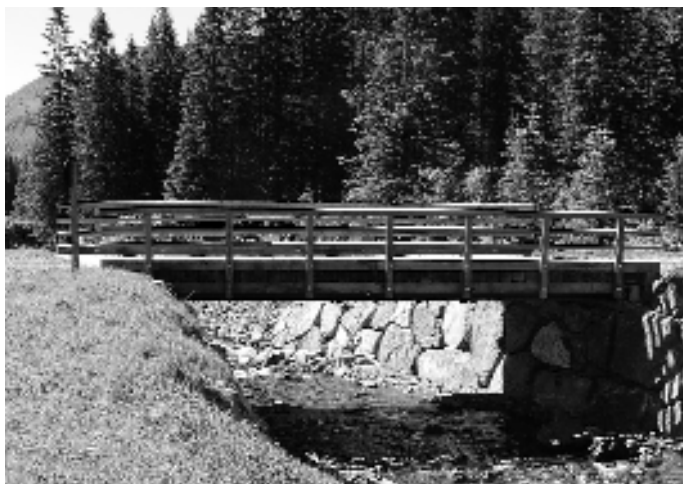
Stahl-Holzbrücke aus Eichenholz der Agrargemeinschaft Altenstadt
